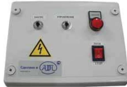
Пульт управления обеспечивает следующие защиты: защита от короткого замыкания, защита от перегрузки по току (класс срабатывания 10), защита от недогрузки по току (позволяет избежать «сухого» хода насоса). Коэффициент срабатывания насоса по «сухому» ходу по умолчанию равен 0,7, что означает, что при падении нагрузки до значения 0,7 насос будет отключен. Данный коэффициент может быть перенастроен. Принцип измерения недогрузки по току позволяет избежать использования реле защиты от «сухого» хода.
